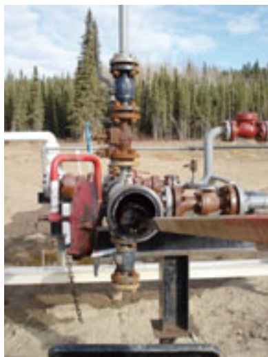
Het plaatsen van een PIG
