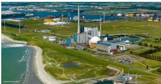
Figuur 3.2 Kernenergiecentrale Borssele
