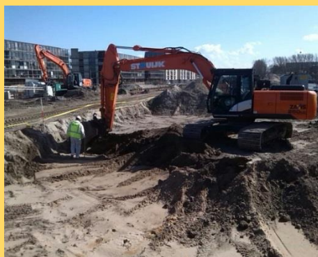
Bodemsanering Spoorzone Delft
