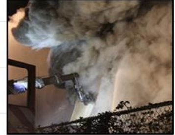
+ 70 Stuk gevel verwijderd
