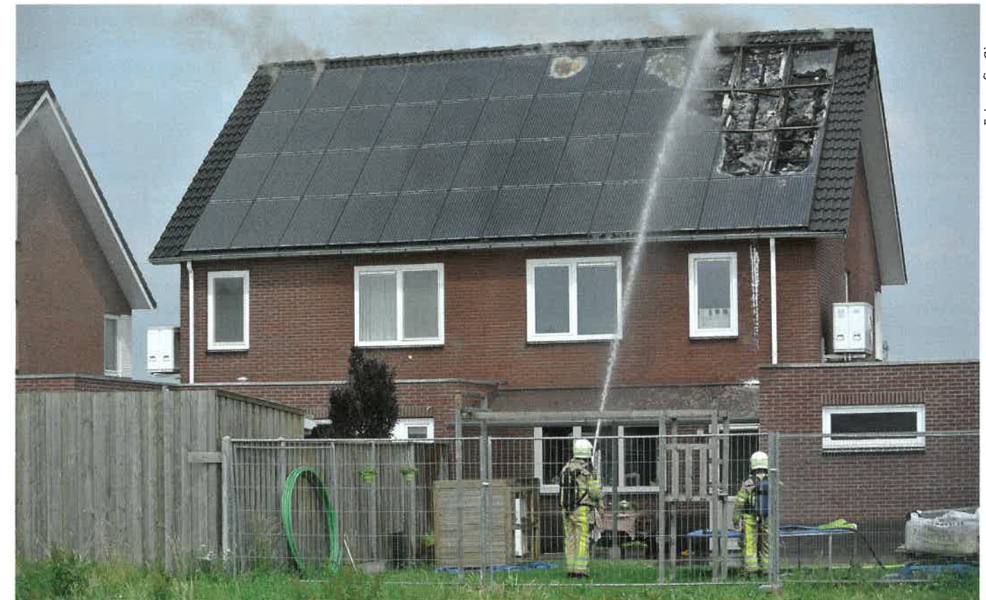
Bij in-daksystemen woedt de brand meestal achter de panelen, waardoor deze lastig te blussen is.
