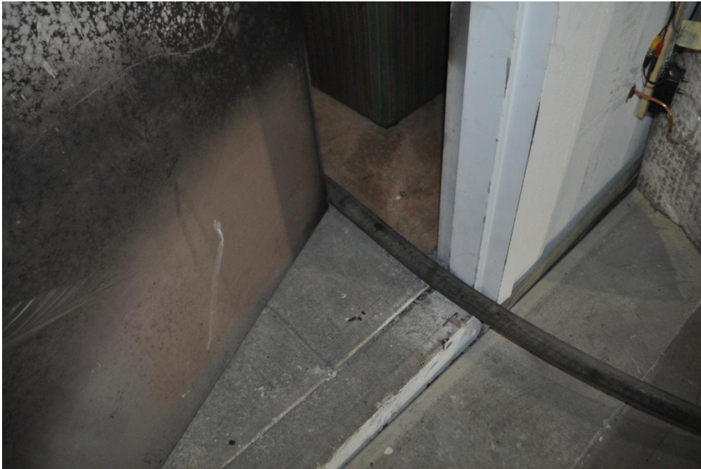
Figuur 4.2: Gecontroleerde deurbediening met een 1 3/4 inch 35 brandslang
