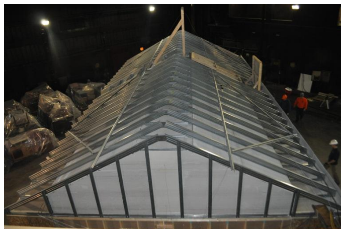
Figuur 3.2: Dak bungalow
