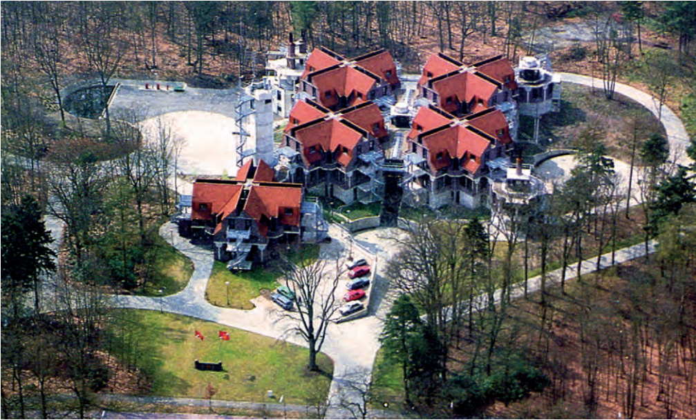
Luchtfoto van voor de verbouwing.
