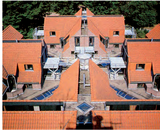
Loopbruggen over het dak vormen de verbinding tussen de verschillende vleugels
