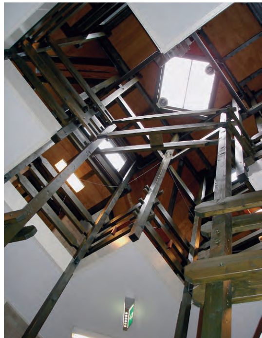
Het trappenhuis in de A-vleugel heeft nog de oorspronkelijke staat.
