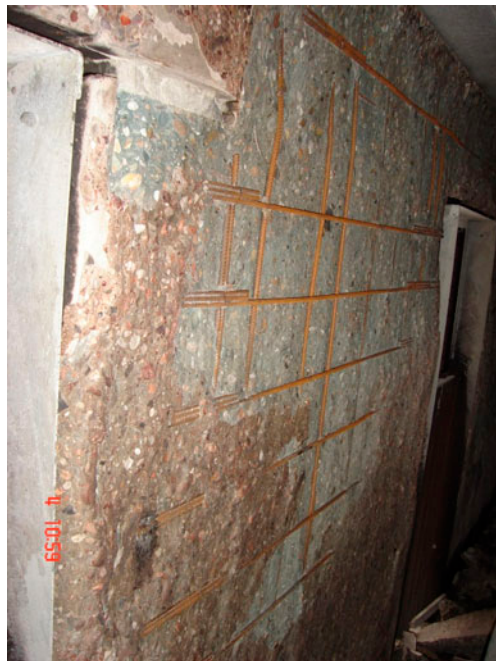
Figuur 13: aanzicht gespat betonoppervlak gevelement
