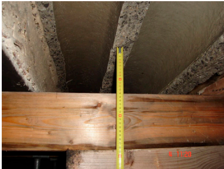
Figuur 19: de in het diagram met groen aangegeven scheur bevindt zich op ca. 14 cm vanaf de voormalige onderzijde van de plaat.
