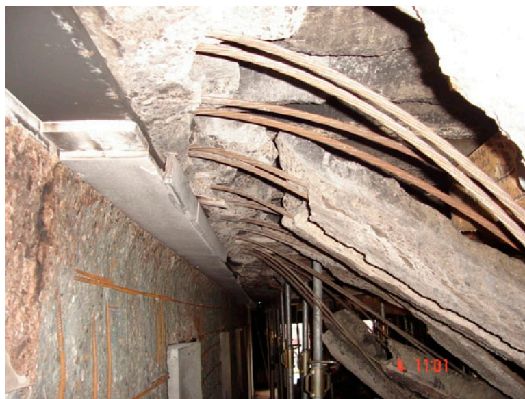
Figuur 15: stalen hoekprofiel is intact, de brandwerende beplating is nog deels aanwezig na afkoelen.
