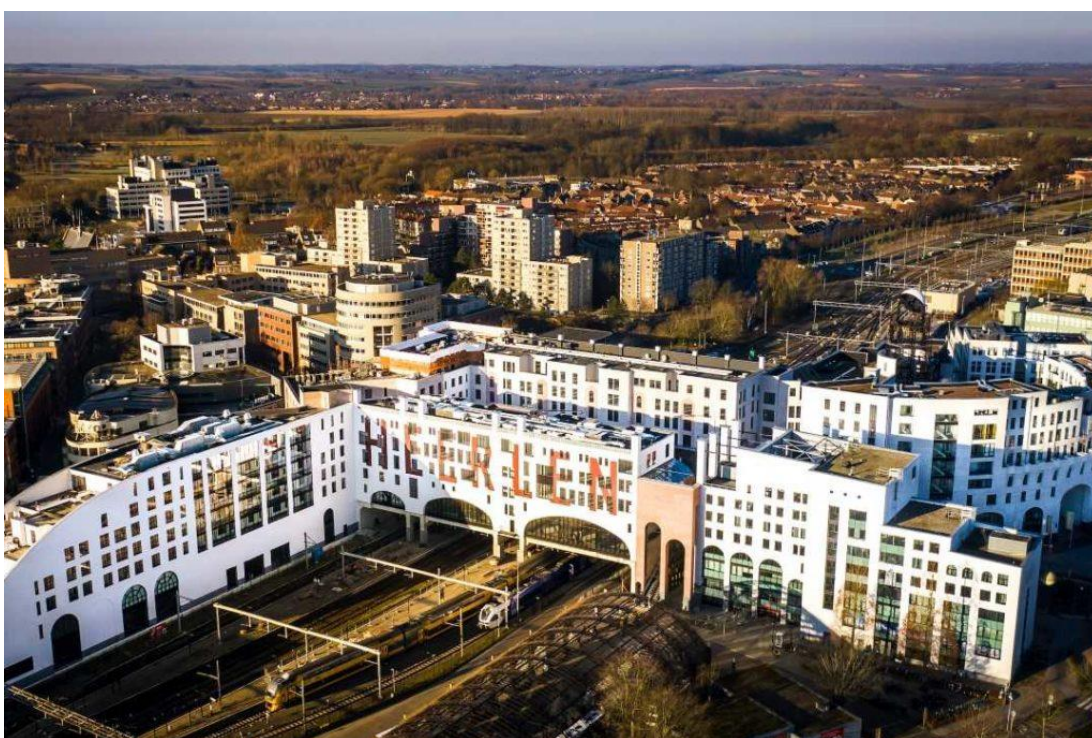
Figuur 2.1 Het Maankwartier in Heerlen waarbij woningen en winkels boven het spoor zijn gebouwd
