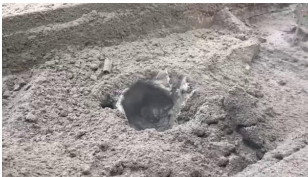
Afbeelding 3.1 Beeld van de leidingbreuk (foto: Veiligheidsregio Haaglanden)
