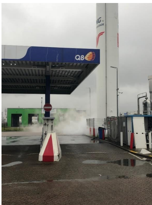
Afbeelding 8.1 Lekkage van de LNG-tank (foto: Veiligheidsregio Rotterdam-Rijnmond)
