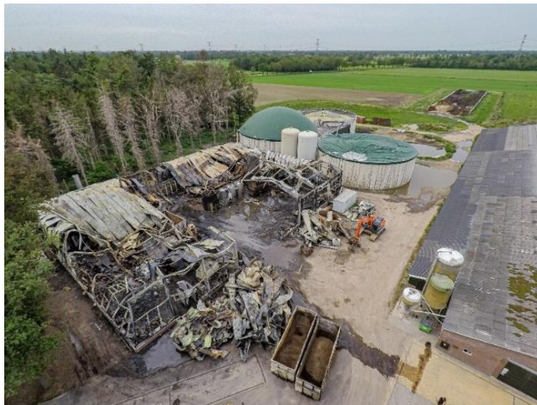
Afbeelding 5.2 Schade na de brand (foto: Marcel van Saltbommel)
