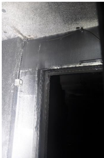
Foto 6: Kozijn van brandwerende deur tussen parkeerkelder en trappenhuis.
