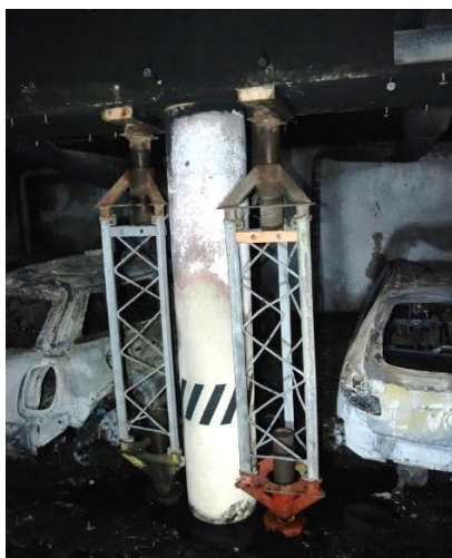
Foto 19: Versterking van de kolommen.
