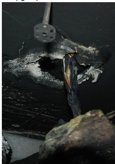
Foto 7: Invoorzijde schacht in kelder naar woningen.
