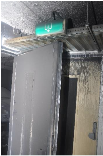
Foto 6: Brandwerende deur tussen parkeerkelder en trappenhuis.
