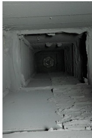
Foto 13: Binnenzijde ventilatiekanaal, vanuit kelder naar dak genomen.
