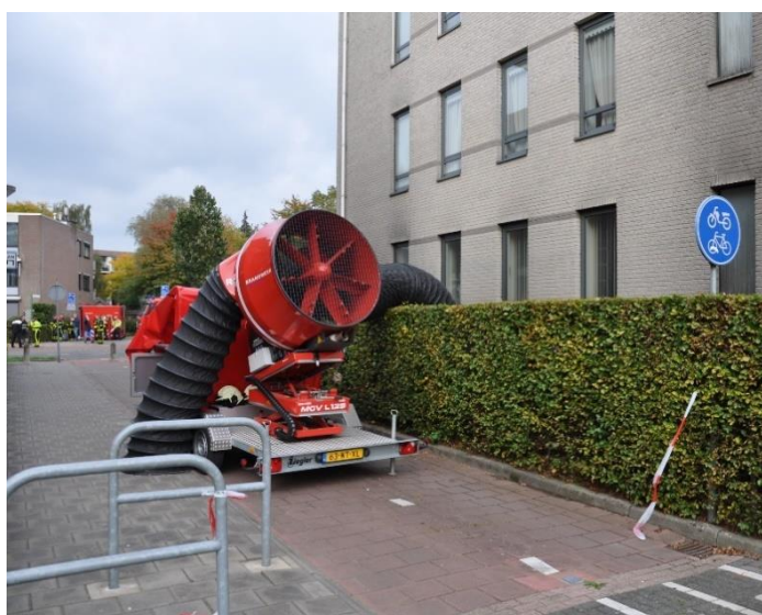
Foto 11: Grote ventilator zuigend ingezet in nooduitgang parkeerkelder.
