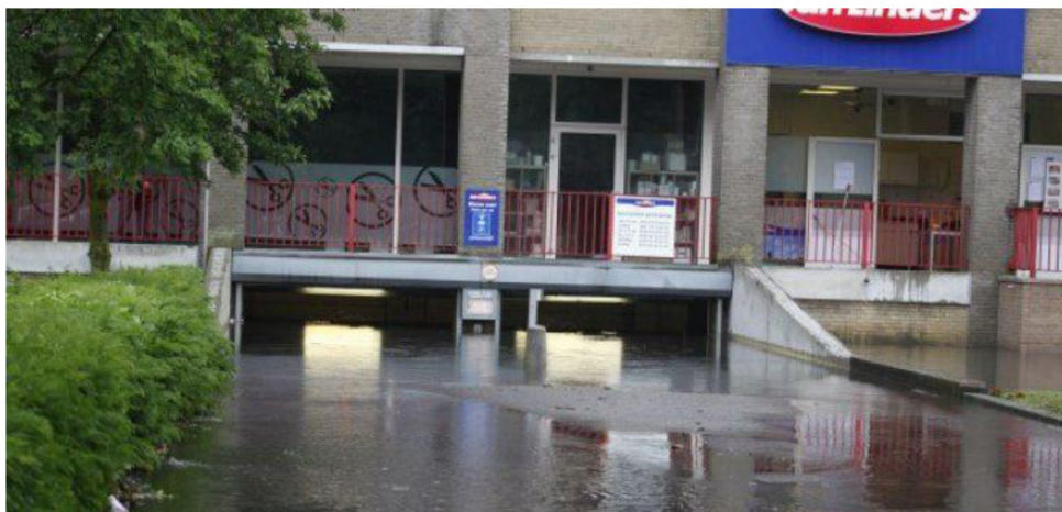
Figuur 4: Volgelopen parkeerkelder na overstroming in Boxmeer, 3 juni 2016. Bron: nu.nl
