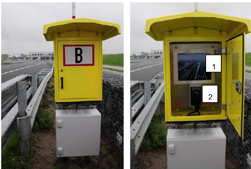
Figuur 7. Hulpdienstinformatiepaneel, links gesloten, rechts geopend; 1: beeldscherm, 2: intercom
