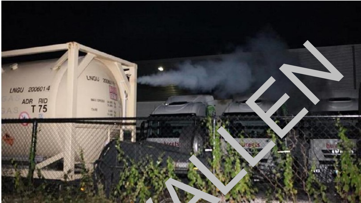
Afbeelding 35: Afblaasventiel in werking (vorming BOG = normaal proces, maar niet gewenst!
