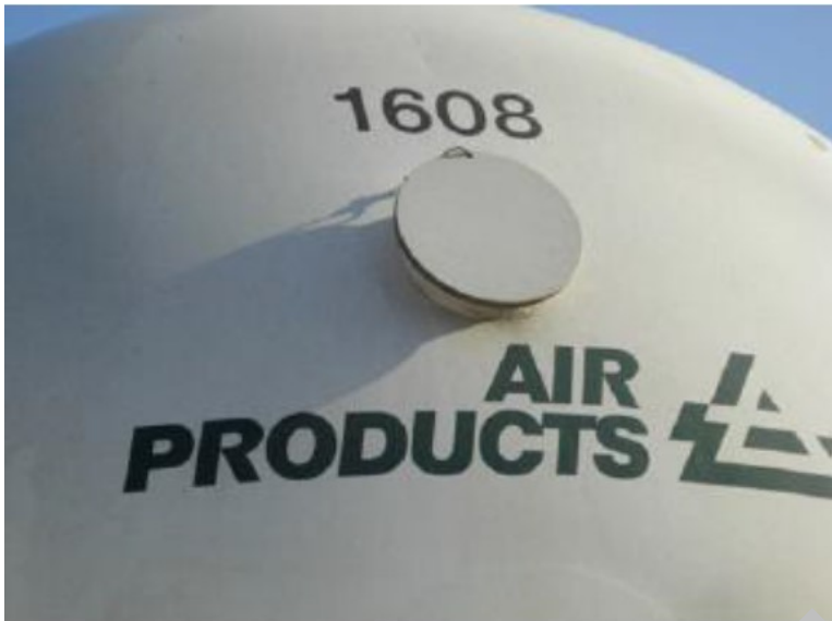
Afbeelding 34: Blow-off disc
