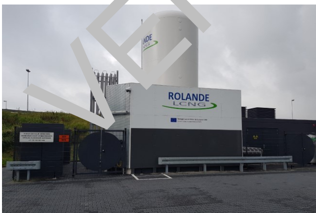
Afbeelding 8: Gerealiseerd brandmuur tussen standplaats lossende vrachtwagen en de LNG installatie (bron: werkgroep)
