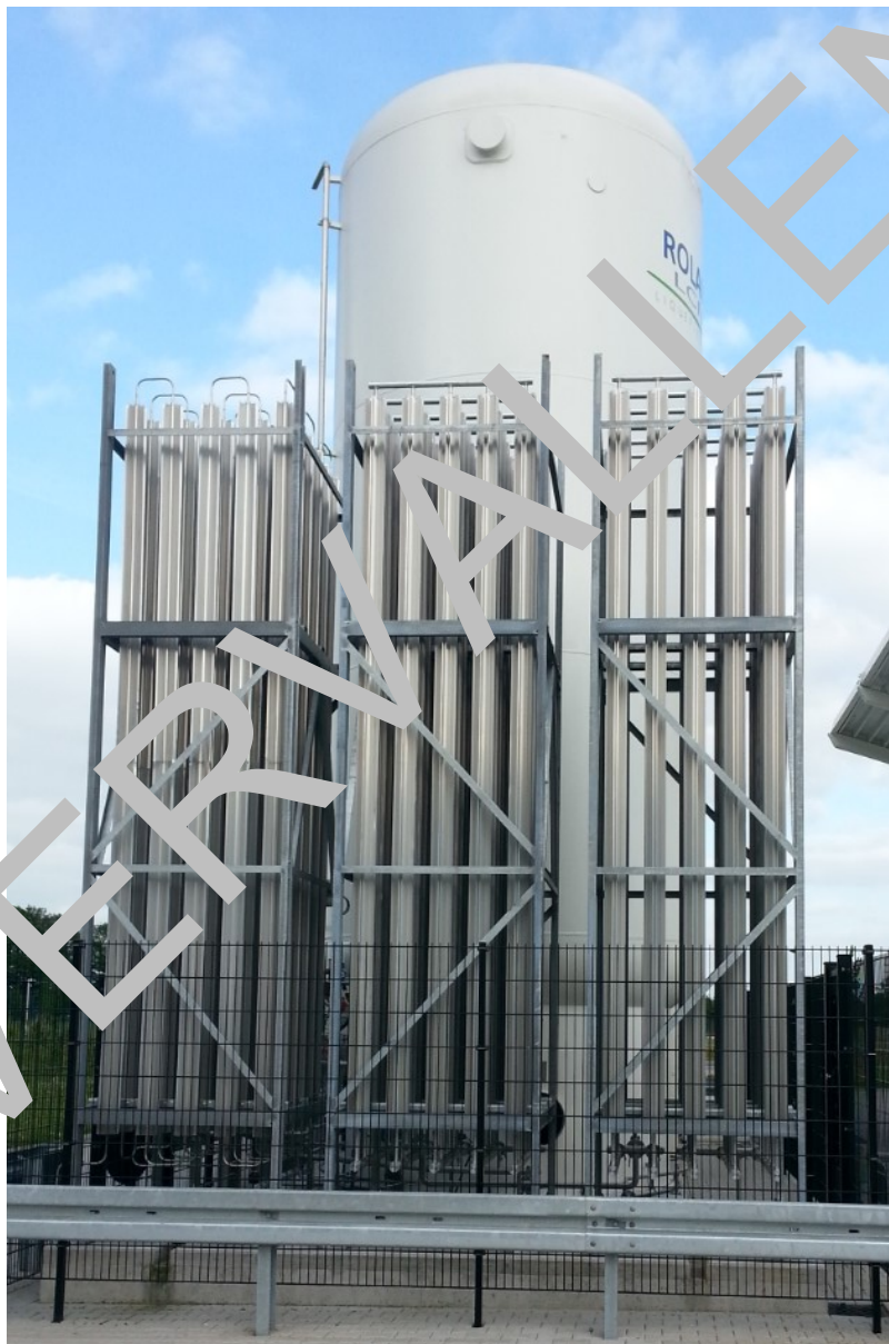
Afbeelding 7: Drukopbouwverdamer (Bron: werkgroep)
