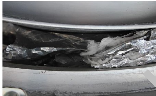
Afbeelding 30: Isolatie materiaal tussen binnen- en buitentank
