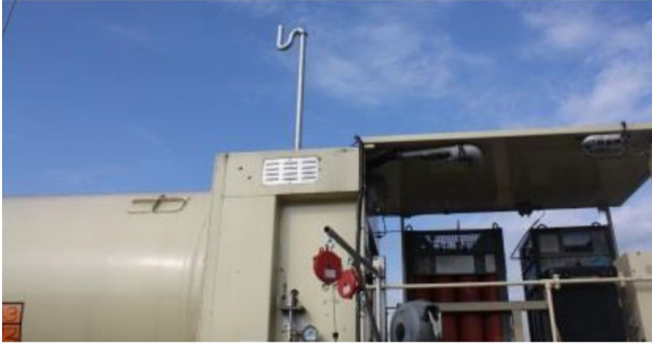
Afbeelding 15: Afblaaspip afleverinstallatie
