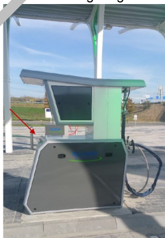
Afbeelding 17:en 18: Twee soorten afleverzuilen met noodknop (rode pijl)
