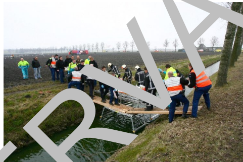
7 Provisorische bruggen van uitklapbare ladders en planken aangelegd over sloten
