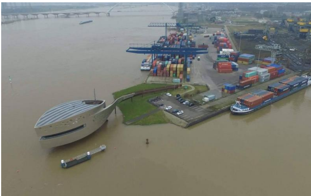
Figuur 3.2 De verkeerspost Nijmegen (bron: Verkeerspost Nijmegen)
