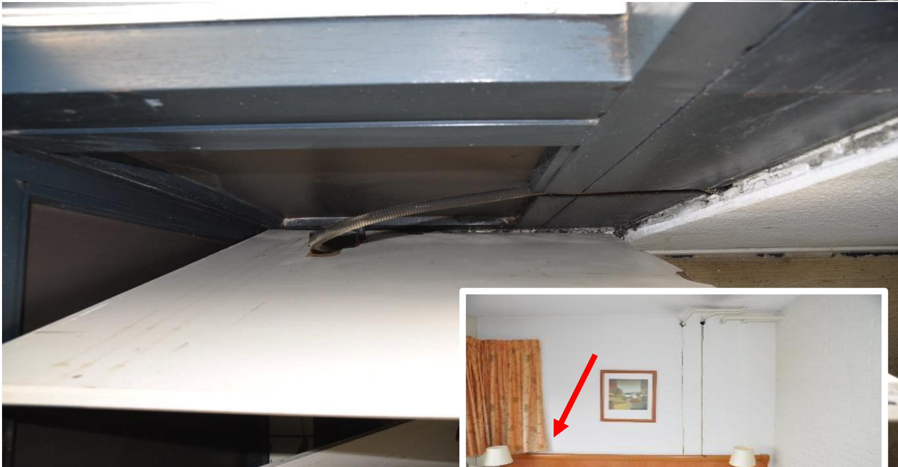
Rook via toevoer leiding stopcontact
