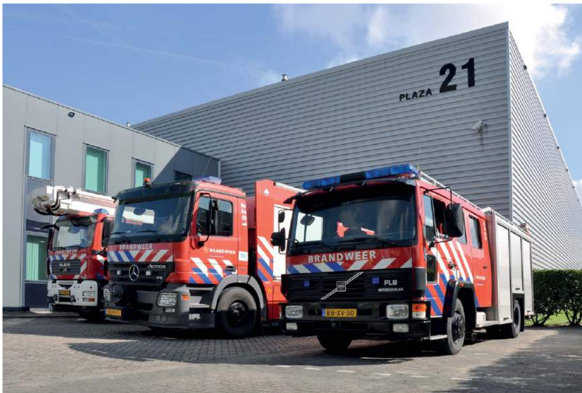
Figuur 4.3: Brandweerpost Moerdijk-Haven (Bron: Gemeente Moerdijk)
