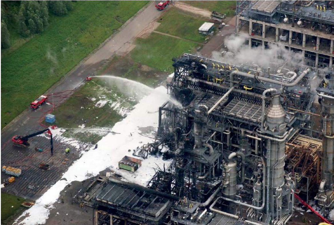
Figuur 4.6: Nablussen bij de MSPO2-installatie. (Bron: ANP/B. van de Biezen)
