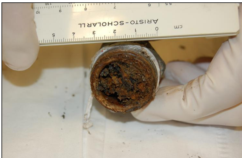
Afbeelding 14: Verstopte ontluchting van de vuilwatertank (foto: TNO Bouw en Dienstverlening)
