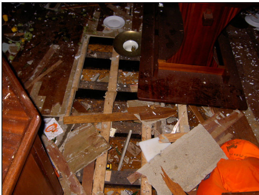
Afbeelding 5: Schade na de explosie, vloer verblijfsruimte (foto: Onderzoeksraad voor Veiligheid).
