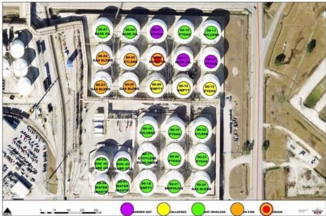
Afbeelding B1.1 Inhoud van de tanks en de mate waarin de opslagtanks verloren zijn gegaan (Courtesy/www.interm.com)
