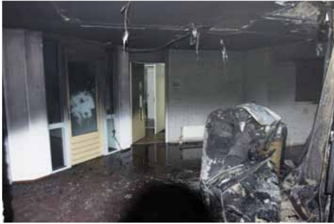
Afbeelding 29: 1 e Verdieping toegang tot centrale ruimte
