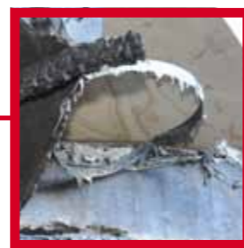
Afbeelding 16: Doorvoer van de afvoerpijp de flat in waarbij de bevestigingsring nog zichtbaar is.
