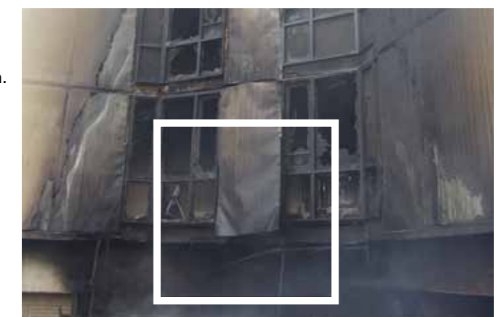
Afbeelding 23: Losse gevelpanelen
