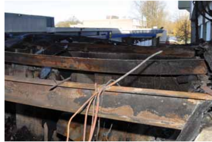
Afbeelding 13: Vervormde stalen draagbalken
