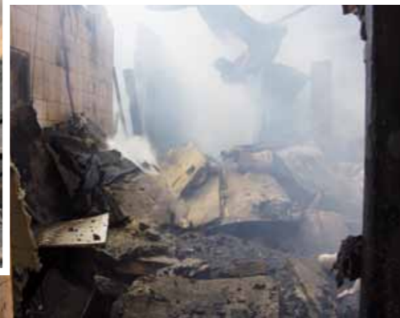
Afbeelding 12: Steenwolisolatie afkomstig van de dakconstructie van de snackbar
