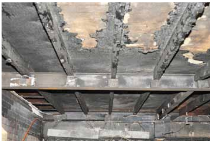
Afbeelding 11: Draagbalken aangetast
