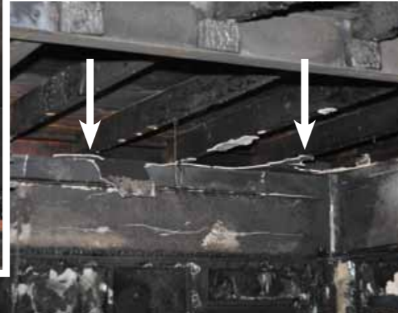
Afbeelding 10: Resten gipsafwerking
