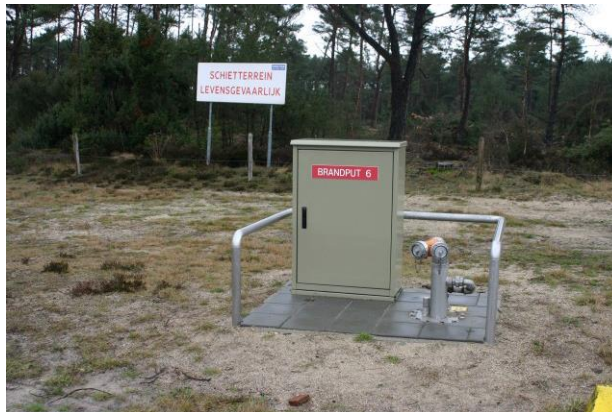
Brandput met elektrische aangedreven bronpomp op het Artillerie Schietkamp 't Harde
