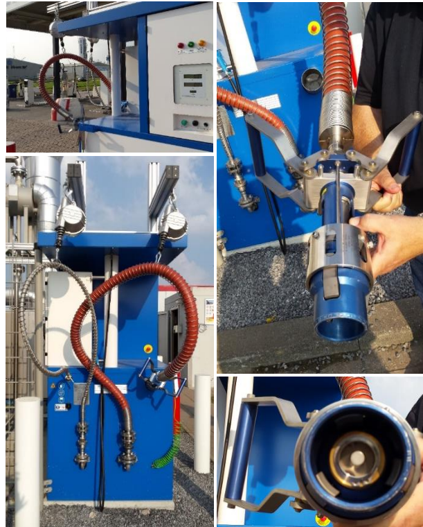
Afbeelding 7.5 LNG-afleverzuil met afleverslang en koppeling
