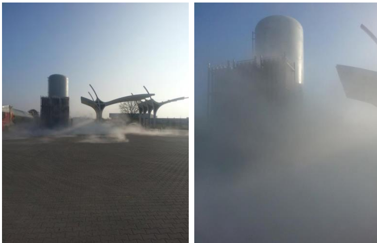
Afbeelding 7.1 LNG-tankstation na het lossen van LNG in de vroege ochtend
