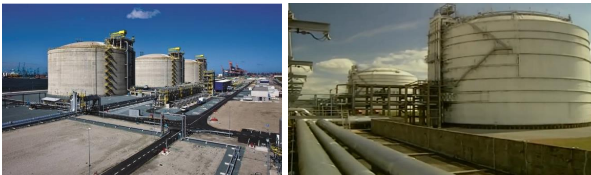
Afbeelding 4.1 en 4.2 Opslagtanks tot 160.000 m 3
