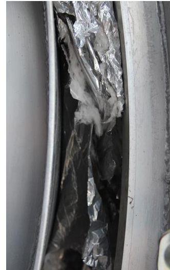
Afbeelding 5.15 Isolatiemateriaal tussen de binnen- en buitentank
