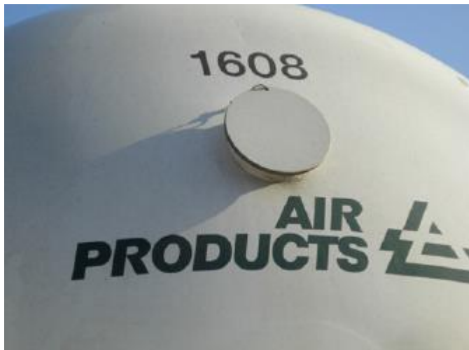
Afbeelding 8.2 Blow-off disc
