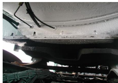
Afbeelding 5.16 Beschadiging isolatie is te herkennen aan ijsvorming aan de buitenkant
