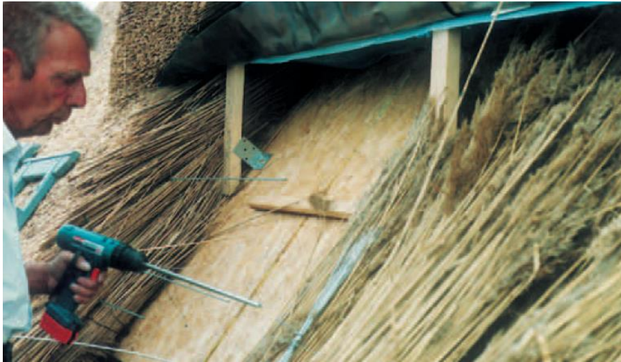
Afbeelding 1.5 Rietdekker brengt riet aan op gesloten schroefdak
