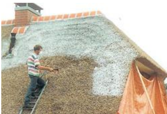
Afbeelding 4.2 Aanbrengen brandvertragend middel
