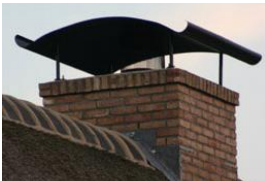
Afbeelding 4.5 Onder deze schoorsteenkap is een vonkenvanger geplaatst
