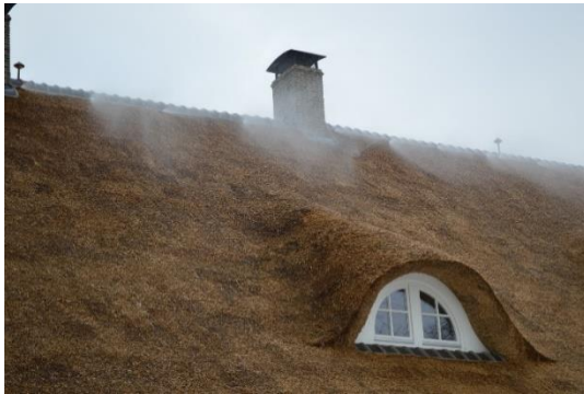
Afbeelding 4.4 Sprinklerinstallatie
