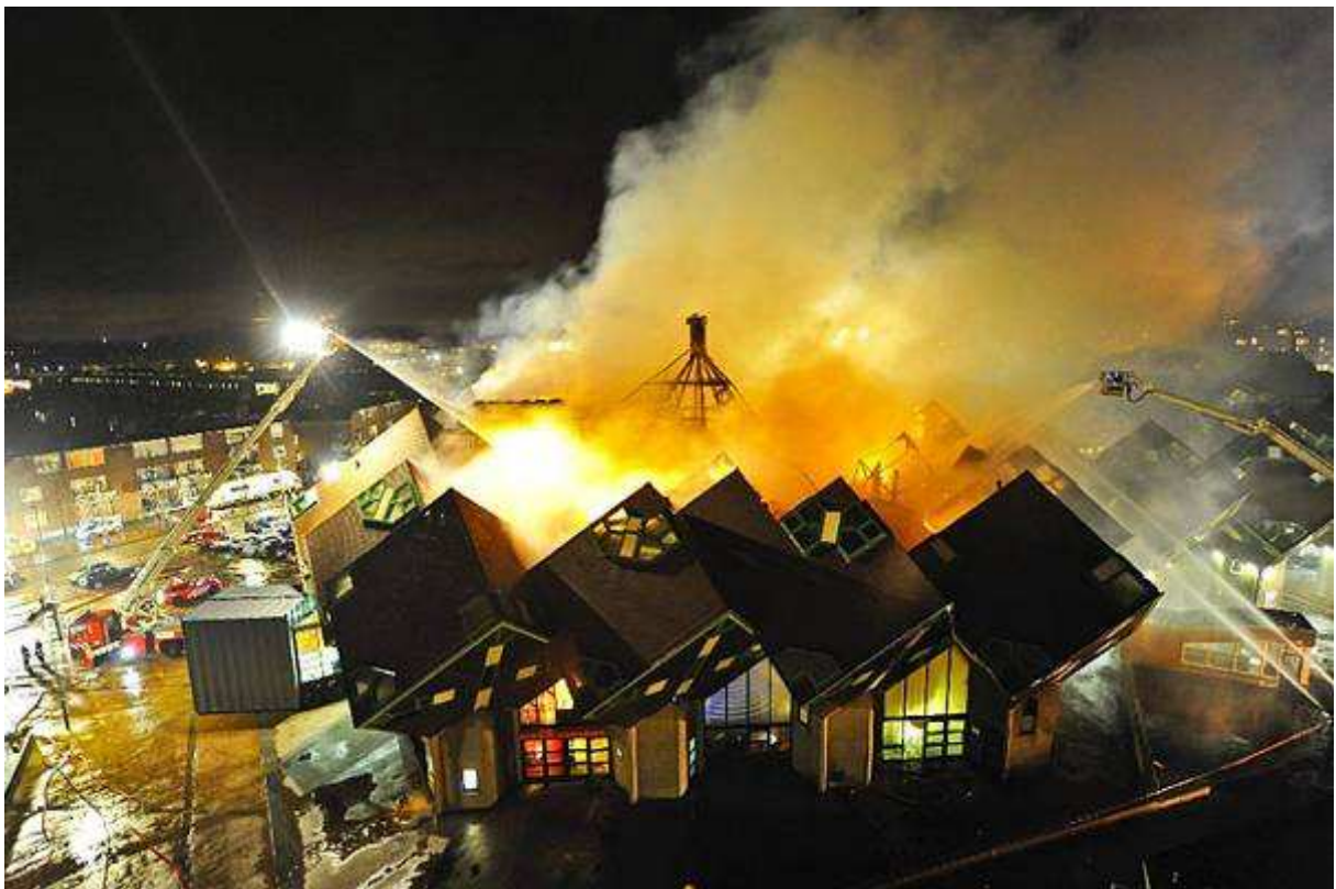
Foto 31: Overzichtfoto 't Speelhuis
