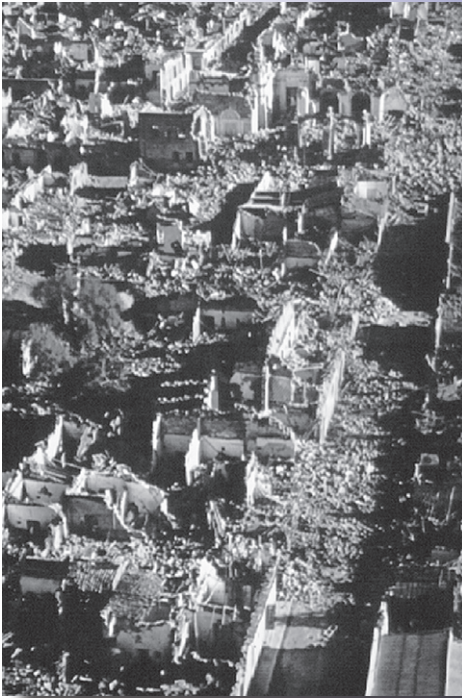
Het plaatsje Montevago op Sicilië werd totaal verwoest door een tamelijke zwakke aardbeving die echter op geringe diepte plaatsvond. Door de slechte bouwwijze met gestapelde ruwe stenen en zware daken waren de gebouwen niet bestand tegen de seismische trillingen.
